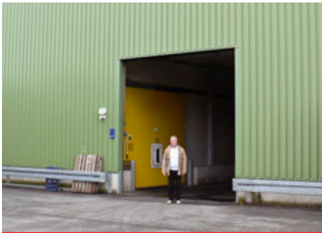
Lagerhalle aus Sandwichelementen der Firma Elbe-Obst in Bassenfleth
