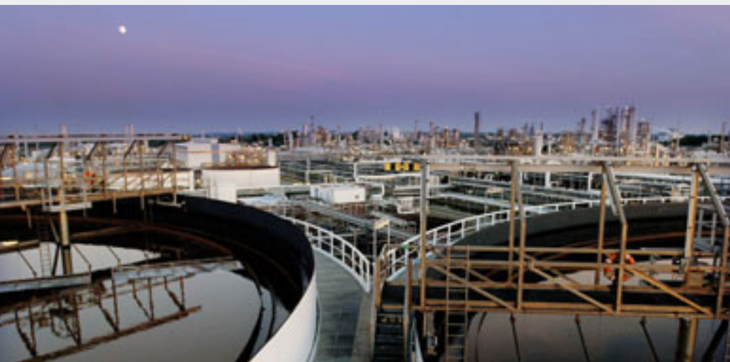
Blick von den Klärtürmen über das Dow Werk
